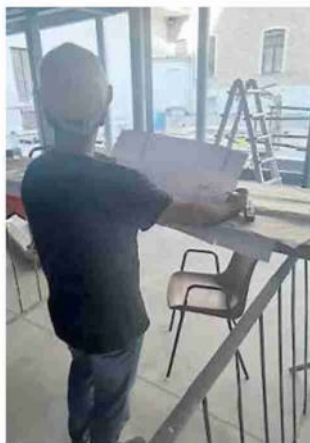
I lavori all'oratorio
